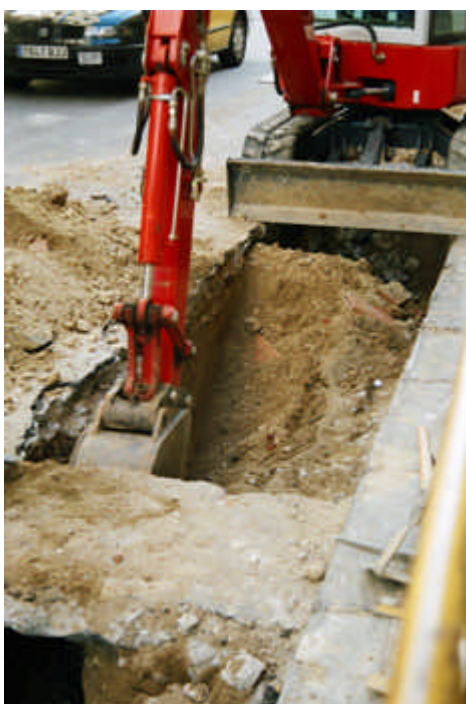
Foto 8: Obertura a màquina de la rasa 300.
