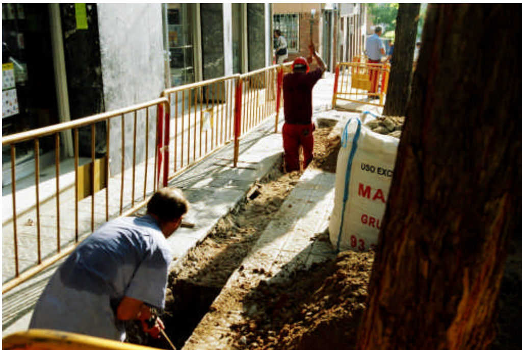
Foto 7: Obertura a mà de la rasa 700.
